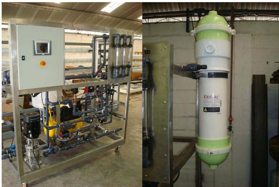
Figura 4.4 – Unidade de ultrafiltração (esquerda) e módulo instalado (direita)
